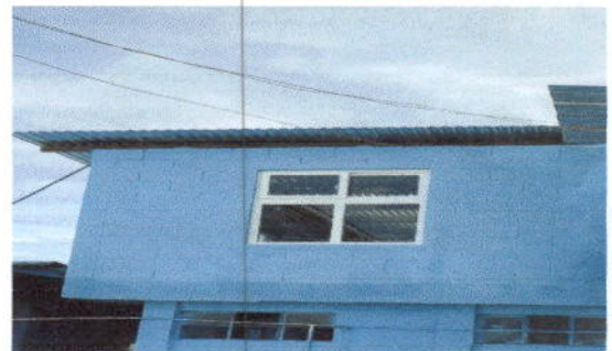
Foto 4: Sustitución de estructuras de metal de ventana a pvc en aula.
