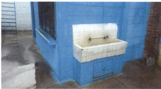
Foto 9: Sustitución de lavamanos en la parte de enfrente de los baños.
