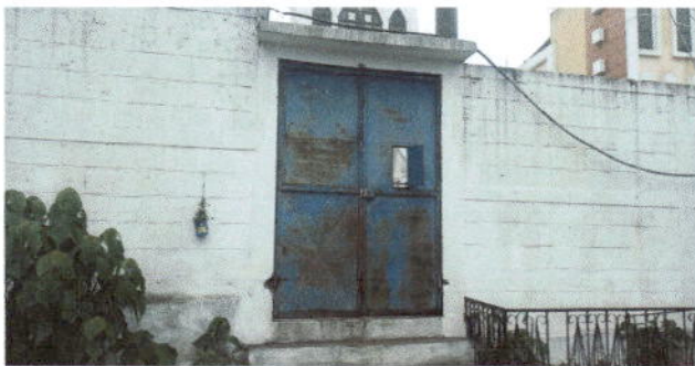
Foto 3: Sustitución de portón en entrada principal.
