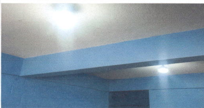
Foto 11: Sustitución de plafoneras y lamparas tipo led a focos en aulas.
