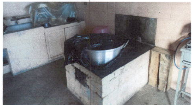
Foto 12: Sustitución de estufa rural completa incluyendo chimenea y plancha de metal en cocina.
