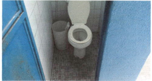
Foto 8: Sustitución de inodoros y sus accesorios
