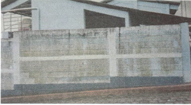
Foto7: Pintura de muro exteriores en entrada principal.
