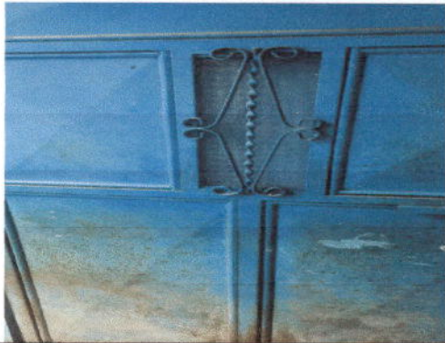
Foto1: Sustitución de puerta en dirección
