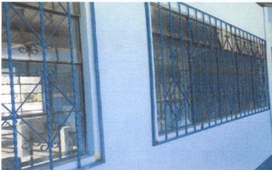
Foto 5: Sustitución de balcones en aula.
