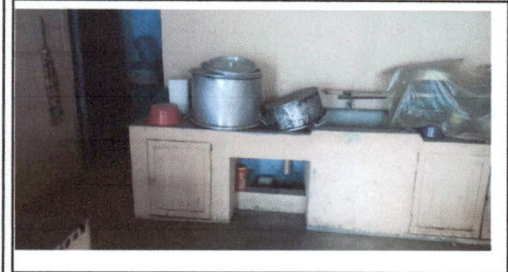
Foto 13: Sustrucción de pila de dos lavaderos en cocina.
